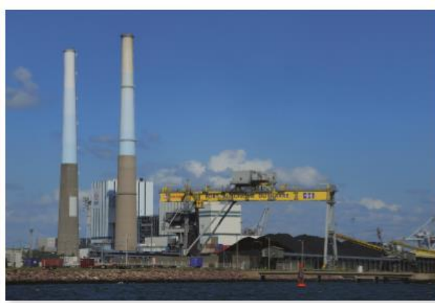
Centrale thermique à flamme.
