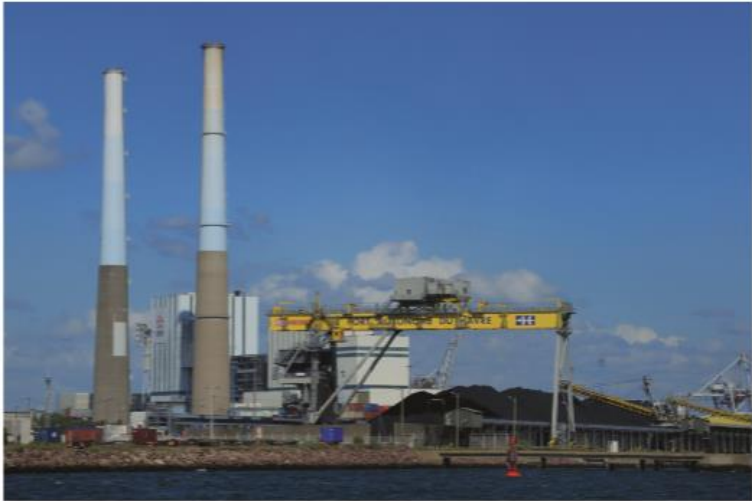
Centrale thermique à flamme. gaz, pétrole, charbon
