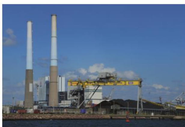
Centrale thermique à flamme.
