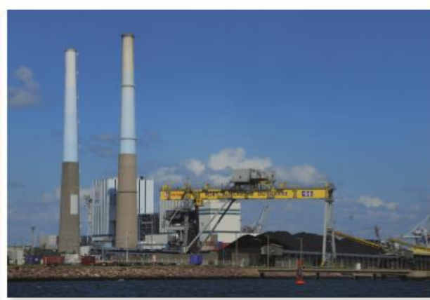
Centrale thermique à flamme.
