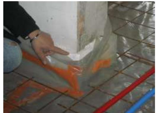
Ensuite, le treillis est installé pour renforcer le béton.
