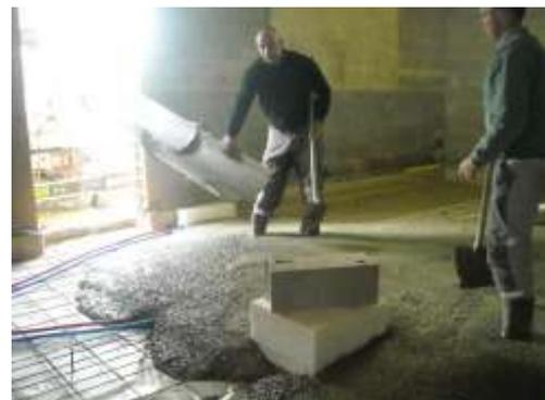
A l'aide d'une barre à débuller, il retire les bulles d'air dans le béton fluide pour parfaire la planéité.
