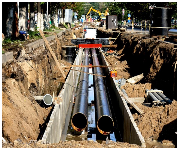
Document 4 : canalisation pour la distribution de l'eau potable
